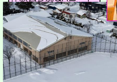
ドローンで撮影した本校体育館
